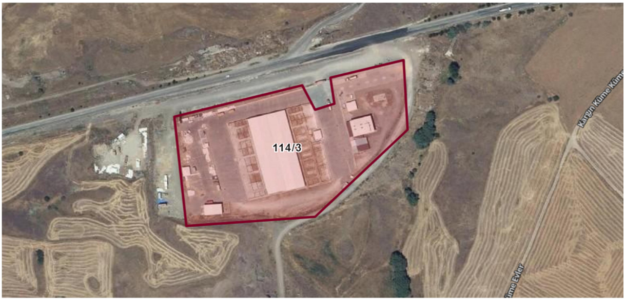
Resim 2.Çubuk Belediyesi Güneş Enerji Santrali Proje Sahası
