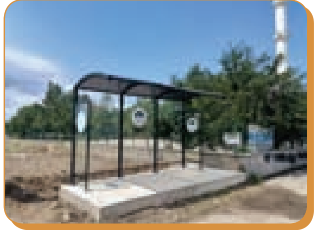
► Atatürk Mahallesi 2 adet durak Yapımı (1 Camlı – 1 Metal)
