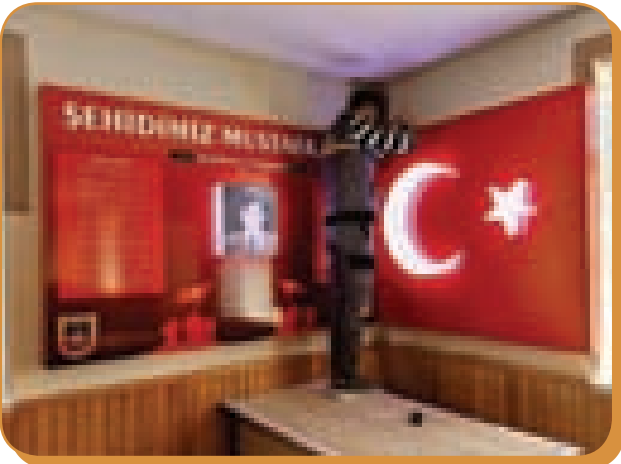
► Eğrikin Mahallesi Şehitlik Köşesi Yapımı
