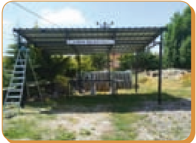
► Mutluköy Mahallesi Sundurma Yapımı
